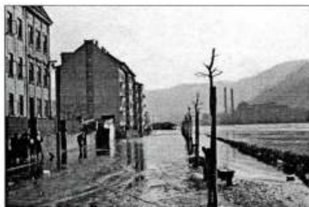
Zaplaveneé střeokouské nábleží 24.3.1940
